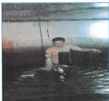
ภาพถ่ายที่ 2.2-11 การล้างทำความสะอาดถังน้ำใช้
