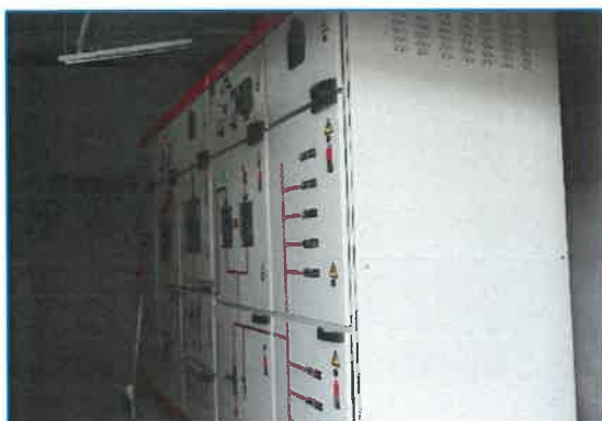
ภาพถ่ายที่ 2.2-22 Circuit Breaker ของโรงแรม
