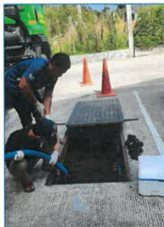
ภาพถ่ายที่ 2.2-17 การดูตกตะกอนจากระบบบำบัดน้ำเสีย
