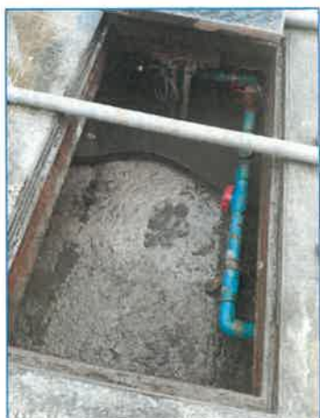
ภาพถ่ายที่ 2.2-17 การดูตกตะกอนจากระบบบำบัดน้ำเสีย
