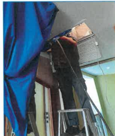
ภาพถ่ายที่ 2.2-31 การทำความสะอาดระบบปรับอากาศและระบบระบายอากาศ
